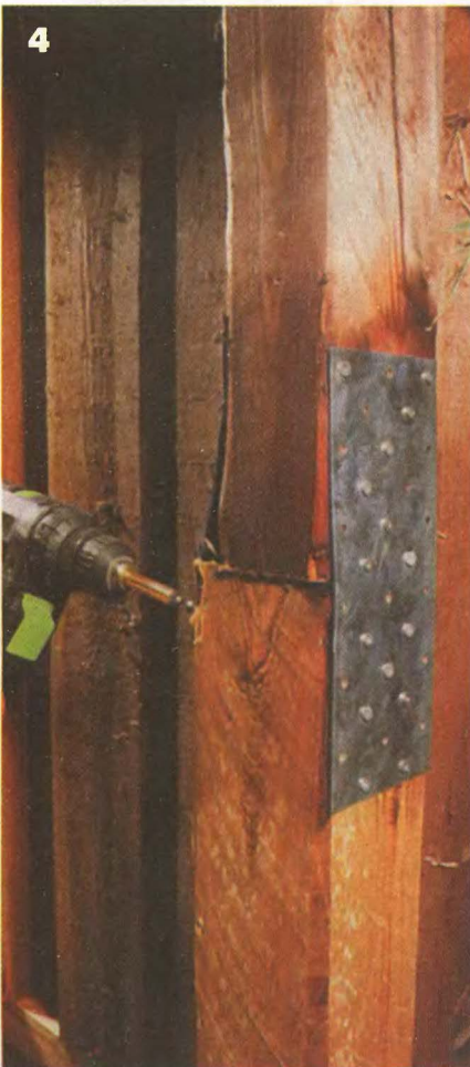
4 Старый столб с новым соединяют скобами или перфорированными накладными пластинами.
