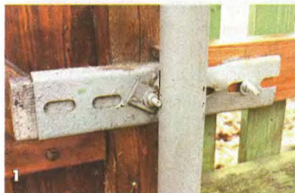
1 Деревянные столбы ворот привинчены к железным столбам при помощи болтов.
