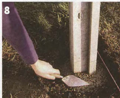
8 Разгладьте поверхность бетона.
