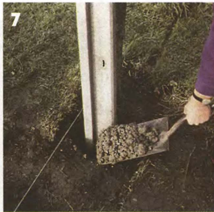
7 Забетонируйте основание стойки.
