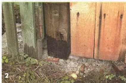
2 Для защиты от сырости деревянные столбы обработаны внизу битумной мастикой.
