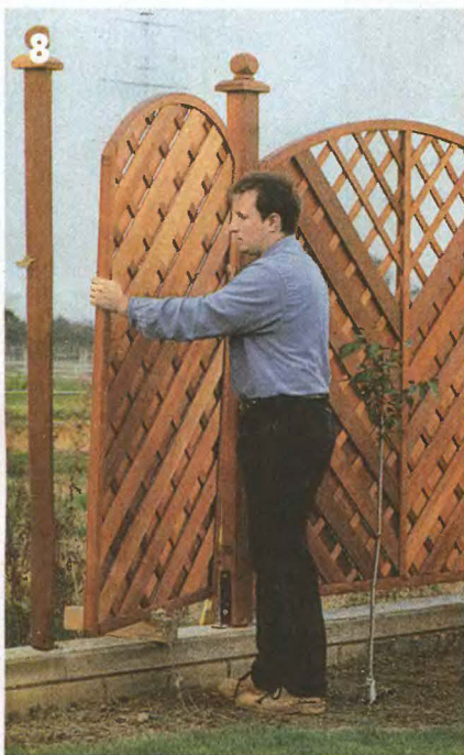
8 Готовые элементы забора (пролёты) монтируют после установки всех столбов.
