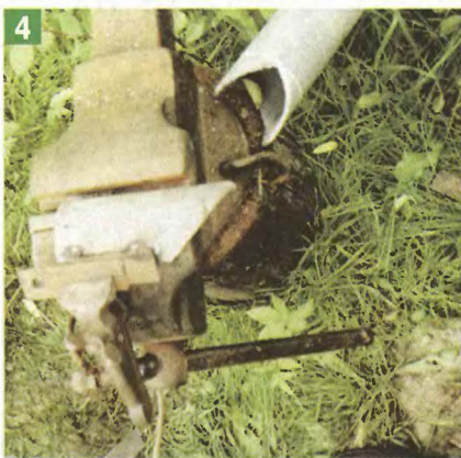
Приваривание к лапе анкера серьги из полоски стали с отверстием.
