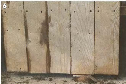
Торцы досок перед окончательным сплачиванием необходимо покрасить.
