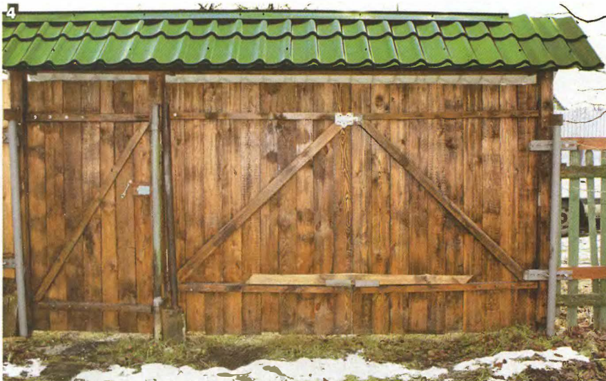
Крепкий рамный каркас с подкосами — гарантия жёсткости створов ворот.
