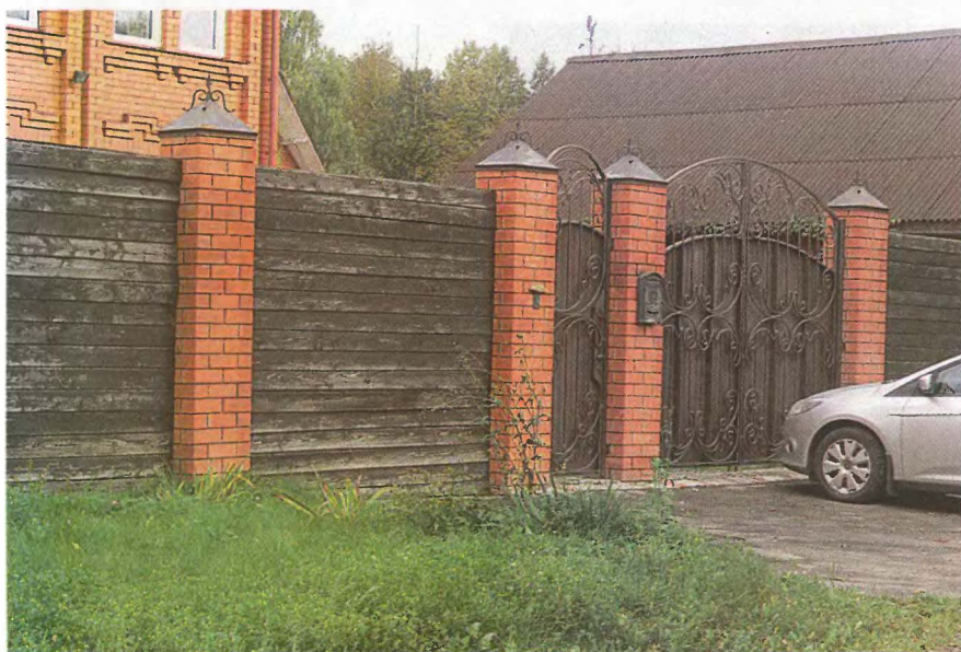
Глухой деревянный забор с горизонтальным расположением досок. Столбы ограды сложены из кирпича.
