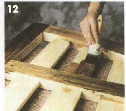
12 Поверхности створки покрывают средством для защиты древесины.
