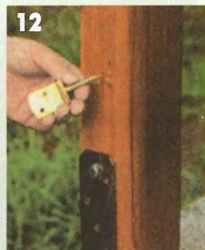
12 Для крепления пролетов используют специальные уголки с антикоррозийным покрытием.
