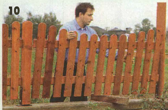
10 Так как это тыльная сторона участка, готовые элементы забора крепят так, чтобы они были обращены к дому штакетинами, а не прожилинами.
