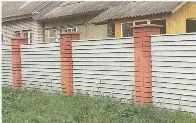
Глухой деревянный забор с горизонтальным расположением досок внахлест. Столбы ограды сложены из кирпича.
