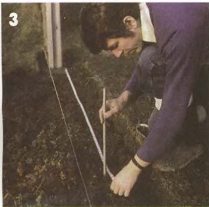
3 Отметьте колышками места стоек.
