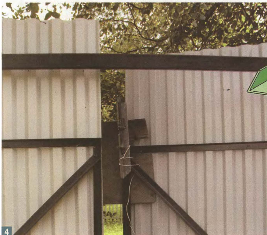
Чтобы приварить задвижку, её надо закрепить в нужном месте и стараться при сварке не испортить крашеную поверхность профнастила искрами раскалённого металла.
