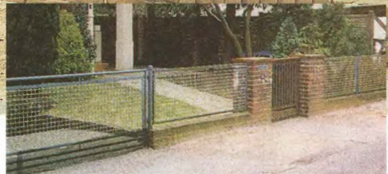
Невзрачно выглядел старый забор из поржавевшей металлической сетки, закреплённой на разрушающихся кирпичных столбах. Ремонт требовался срочный.
