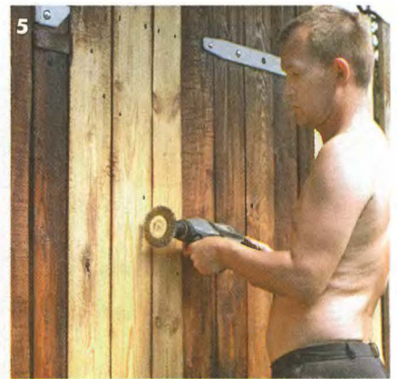
Доски перед покраской брашировал, обработав железной щёткой, установленной на дрели.
