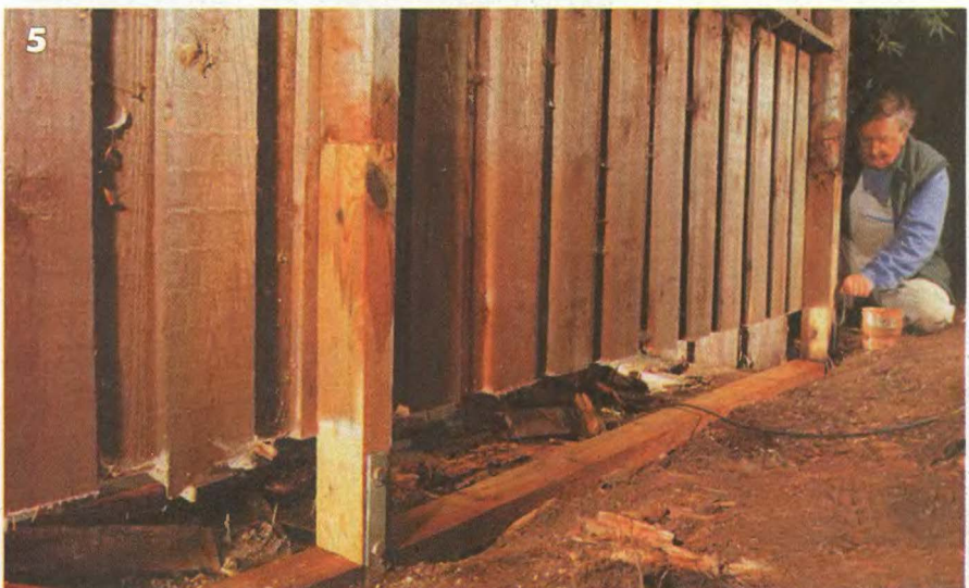
5 Нижние концы новых столбов монтируют при помощи болтов и стальных накладок с зазором примерно в 1 см от закопанного в землю ригеля.
