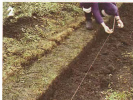
В качестве направляющей для стоек будет шнур, натянутый между вешками.
