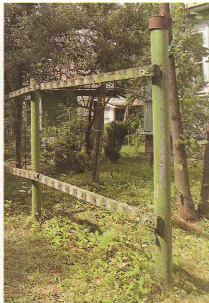
Работу начал с демонтажа старого забора. Его ремонтировал секциями, чтобы не открывать доступ на участок.
