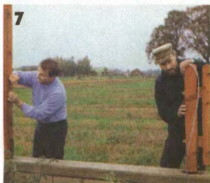
7 Высоту элементов забора контролируют водяным уровнем.
