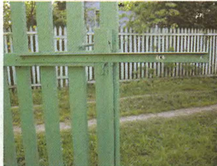
Такой запор для ворот обеспечивает параллельность плоскости их створок.
