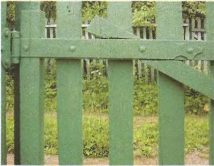
Петли для навеса секций ворот прикреплены болтами, а жёсткость рамы каркаса ворот обеспечивается диагональным брусом.
