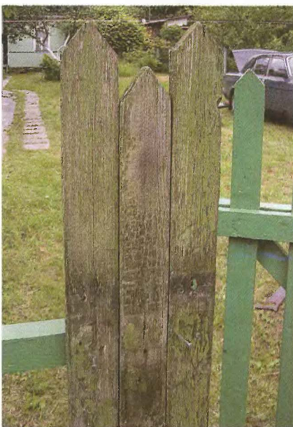
Расстояние между соседними досками в заборе из штакетника равно ширине планки. Шнур из прочной нити позволяет контролировать высоту забора.
