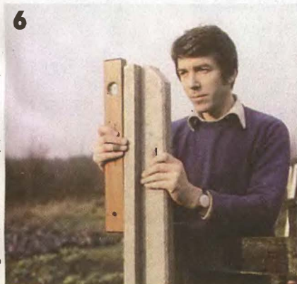
6 Проверьте вертикальность стойки строительным уровнем.
