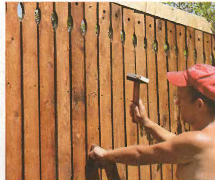
Заключительный этап устройства забора: после крепления досок саморезами каждую прибиваем гвоздями.
