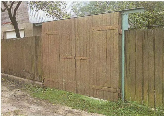
Деревянные ворота на калиточных петлях, приваренных к металлическим столбам.
