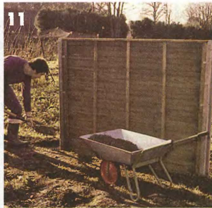
11 Установите следующую стойку.
