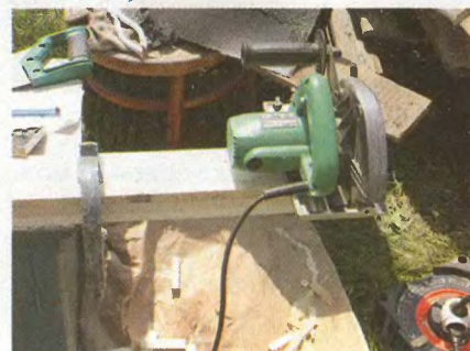
Заготовленные доски удобно торцевать дисковой пилой.
