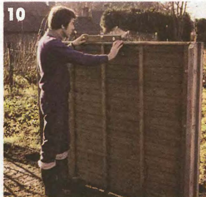
10 Проверьте горизонтальность каждой устанавливаемой панели.
