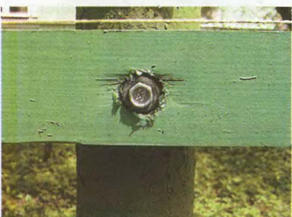
Резиновая прокладка под головкой самореза предохранит от попадания воды внутрь отверстия.
