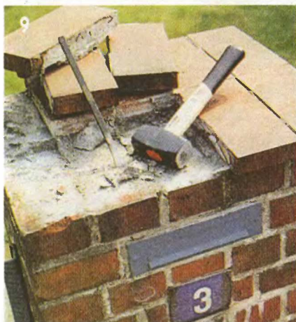
9 Замена покрытия столбов. Сначала кувалдой и зубилом сбивают старые плитки и раствор.
