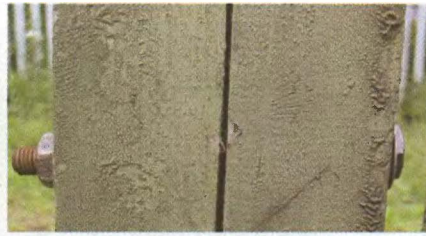
Болты стягивают створки ворот и не дают им деформироваться.
