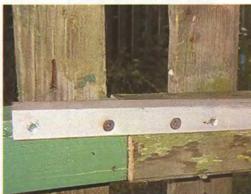
Новую и старую части забора я временно соединял металлическими уголками. Шурупы завинчены только в боковую часть бруса.
