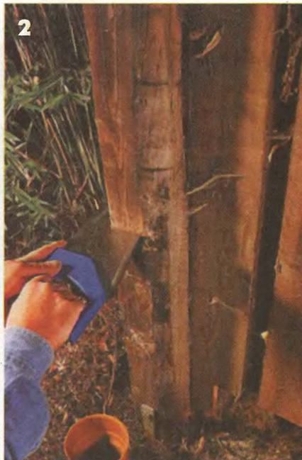
2 Несущие столбы предварительно подпирают (временно дублируют).
