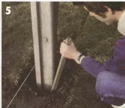
5 Установив стойку, закрепите её утрамбованным крупным щебнем.
