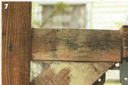
Перекладки тоже обработал специальным составом.
